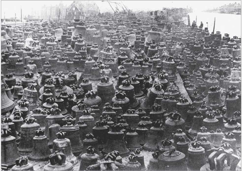
Zentrales Glockenlager in Hamburg. Das Foto zeigt, wie Glocken teilweise aufeinander gestapelt wurden, was leicht zu Beschädigungen führen konnte, auf die auch manche späteren Risse in den abtransportierten Glocken zurückzuführen sind. (Foto: Glockenarchiv, Germanisches Nationalmuseum Nürnberg)
