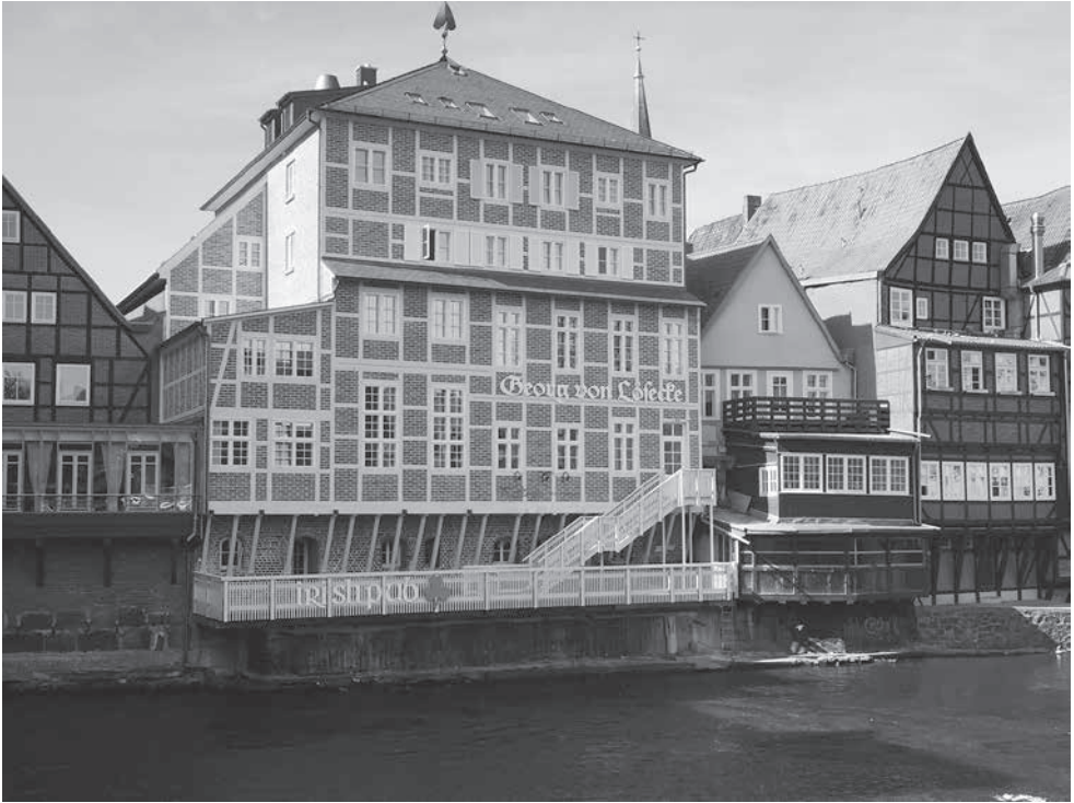
Das wieder aufgebaute „Lösecke-Haus“, März 2017
