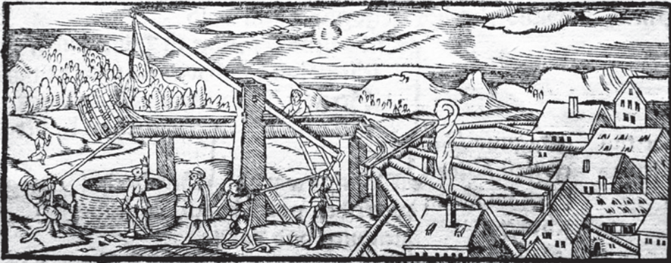
Abb. 1 Brunnen/Sod, Öseammer, Soleleitungen und Siedehäuser der Alten Sülze Aus: Münster's Kosmographie, 1550/1588
