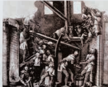
Förderung der Sole, rechts unten Förderereimer
