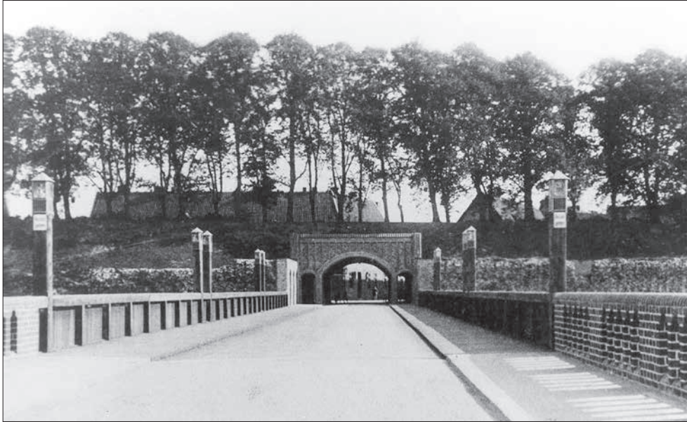
Abb. 6 Foto der Bardowicker Mauer. Aus: Lüneburger Landeszeitung vom 12. 12. 2013. Repro: Boldt
