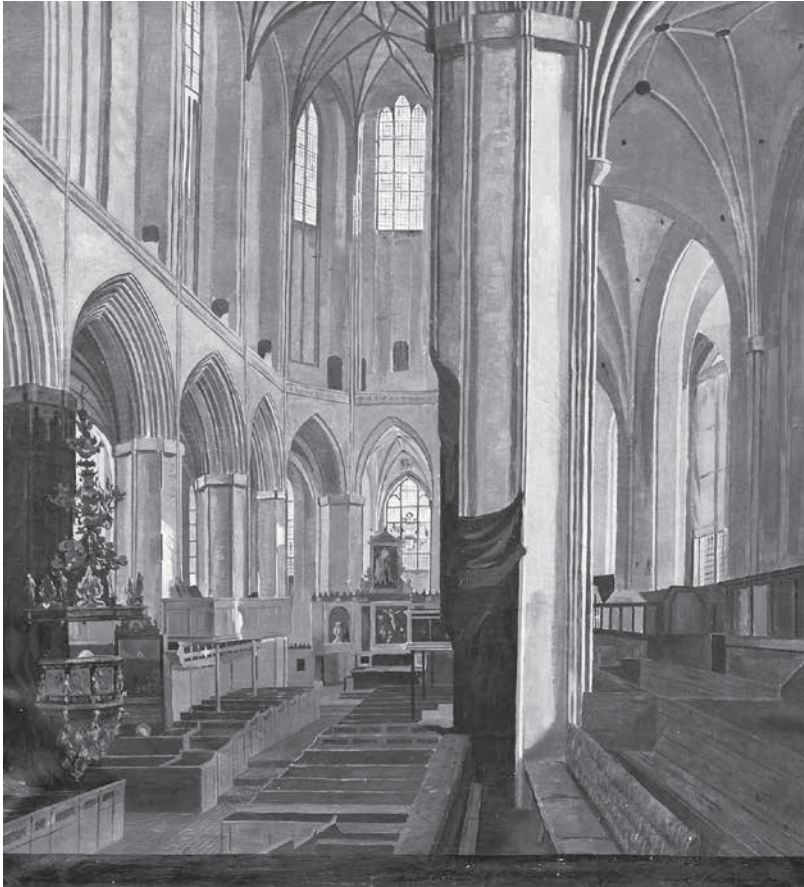
Otto Peters, St. Nicolaikirche 1852 (Foto: St. Nicolai. Lüneburg)
