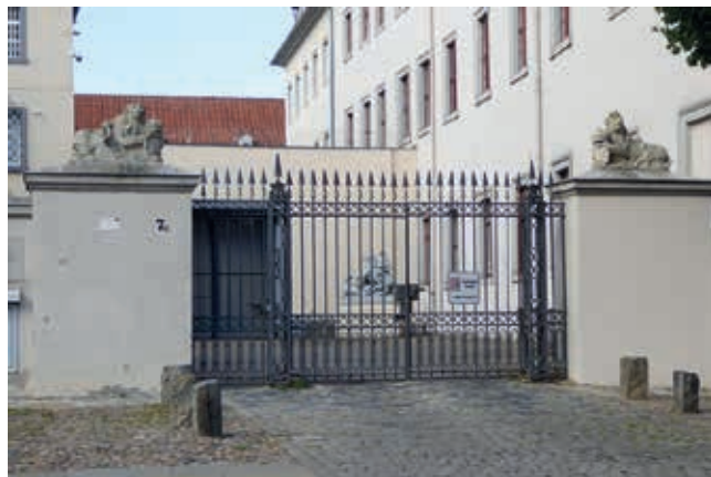
Abb. 4 Portal zum Innenhof (privat, 2022)
